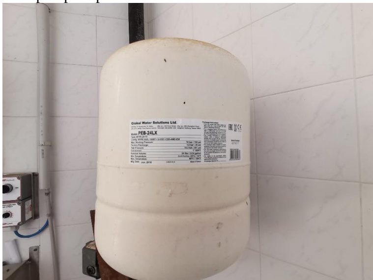
serbatoio del vuoto modello PEB24LX
