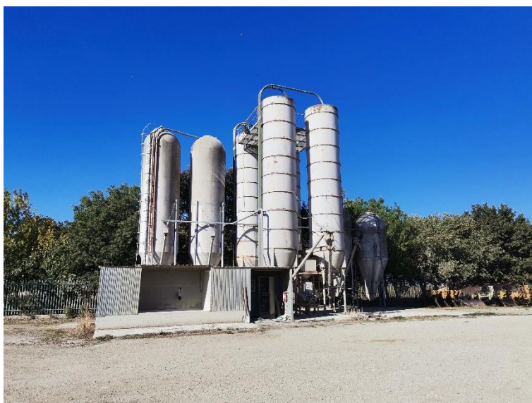
N. 8 silos per mangime animali, tipo 8800, matricola n. 78320, con trituttore ITALVIBRAS, matricola n. 55938
