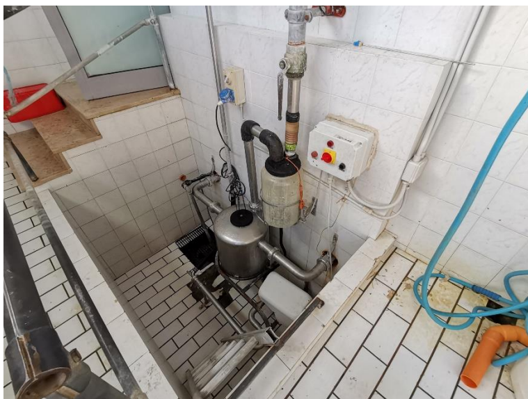
pompa aspira-latte con motore elettrico ELVEM
